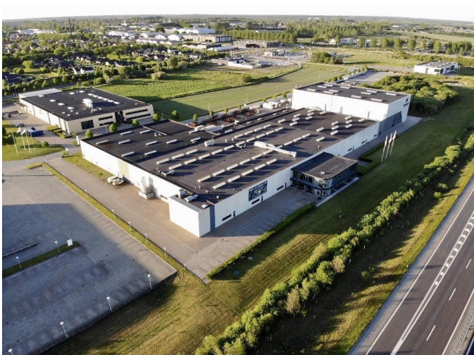
Hovedkvarteret på La Cours Vej 1. Den tilkøbte bygning med "Process Gears" på La Cours Vej 1 ses i baggrunden.
